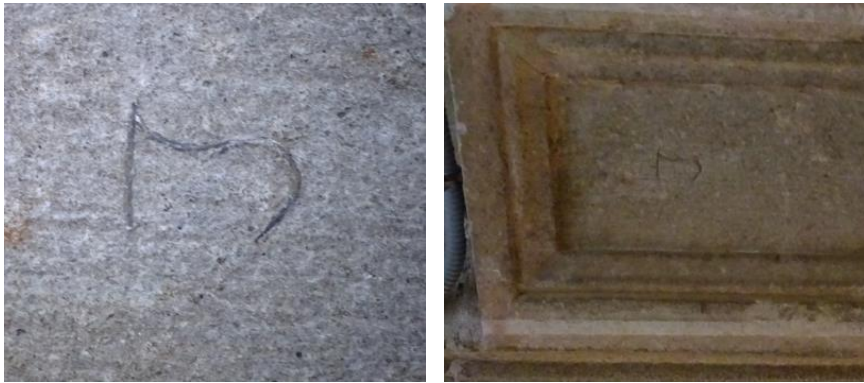
Fotografía 73 y 74. Vista particular y general similar a una J mayúscula, situada en el techo.
