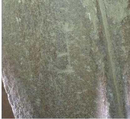
Fotografía 90. Interior de pasamano
