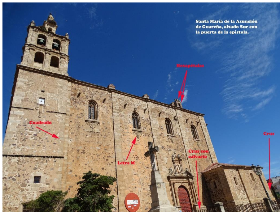
Fotografía 23. Vista general de la cara sur con la localización de las marcas encontradas.
