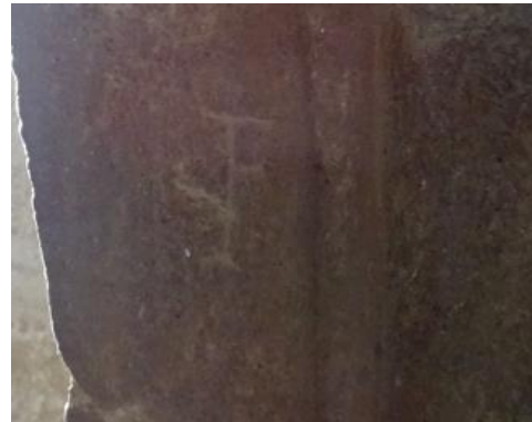
Fotografía 92. Interior de pasamano
