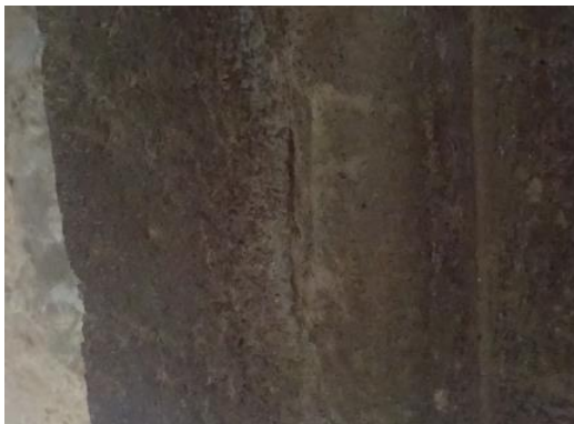
Fotografía 93. Interior de pasamano
