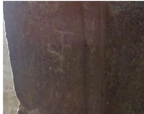
Fotografía 92. Interior de pasamano
