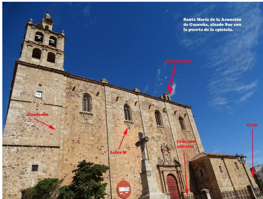
Fotografía 23. Vista general de la cara sur con la localización de las marcas encontradas.
