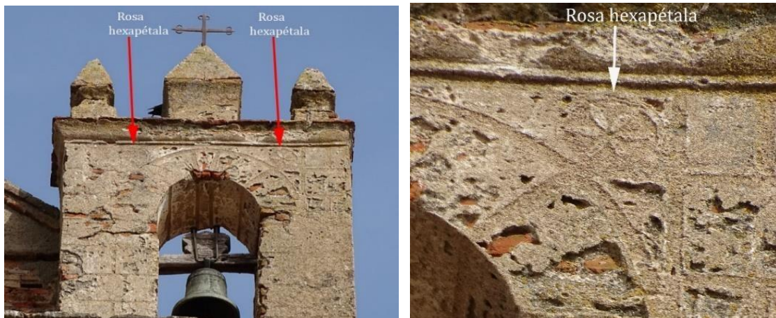
Fotografías 21 y 22. Campanario pequeño situado a la derecha de la puerta de la epístola.
