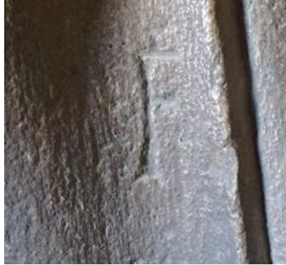
Fotografía 89. Interior de pasamano
