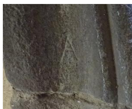
Fotografía 94. Interior de pasamano
