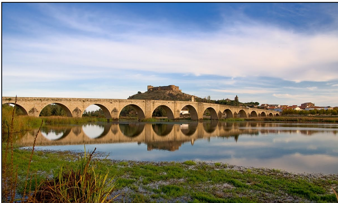
IMAGEN 10. PUENTE DE LOS AUSTRIAS SOBRE EL RÍO GUADIANA A SU PASO POR MEDELLÍN
